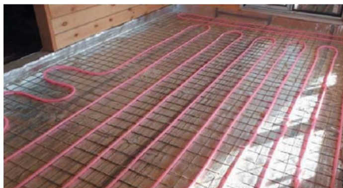
Vytápění dřevostavby, montáž systému
