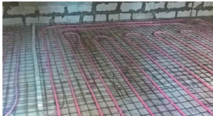
Vytápění objektu z pěnobetonových tvárnic, instalace systému
